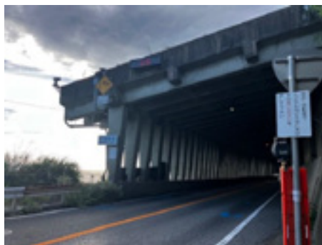
国道 127 号 明鐘トンネル南側入り口
